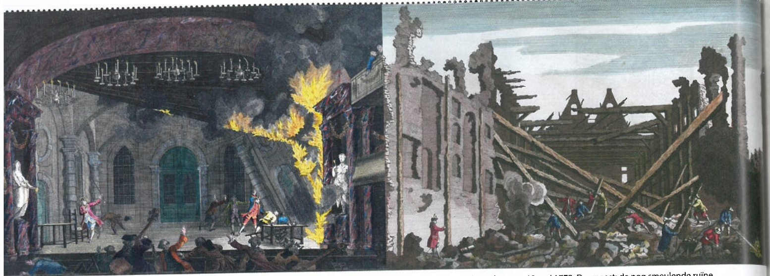
Paniek breekt uit bij acteurs en musici in de orkestbak als de coulissen brandend omvallen in de Amsterdamse Schouwburg op 12 mei 1772. Daarnaast: de nog smeulende ruïne.
